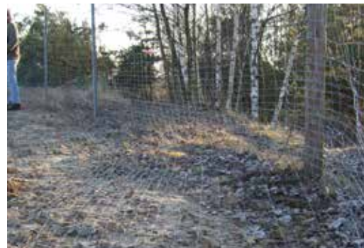
Unterwülschutz mit Knotengeflecht am Boden
